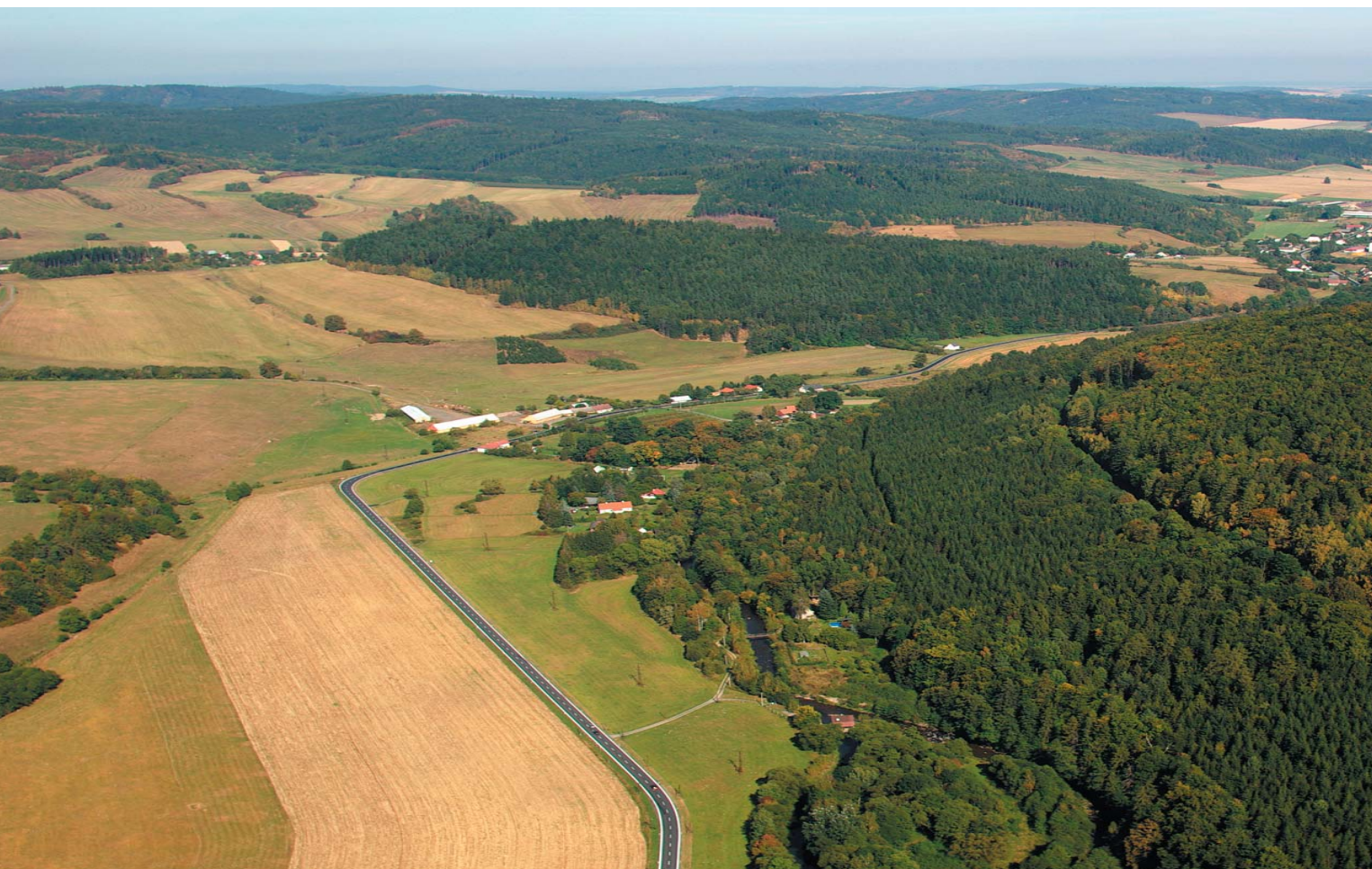
Celkový letecký pohled na oblast nádrže VD Nové Heřminovy. Srovnání současnosti...
