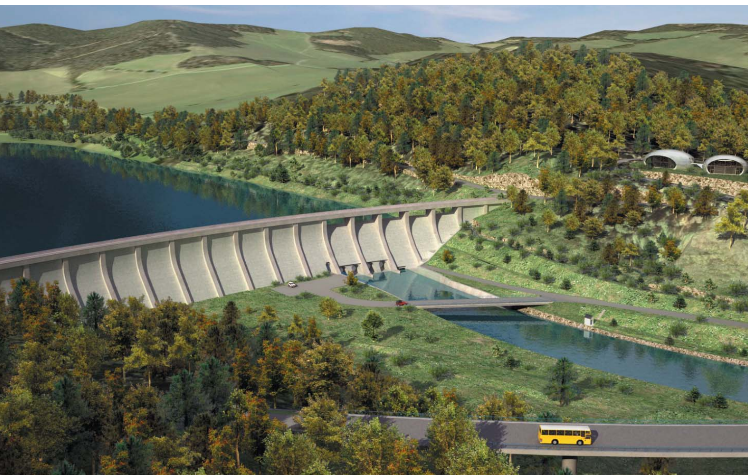
Pohled na betonovou přehradní hráz Nové Heřminovy
